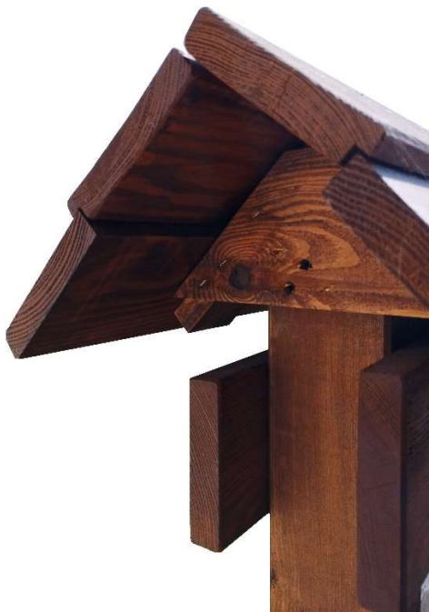
Ryc. 2. Sposób wykonania daszku okrywającego tablicę
