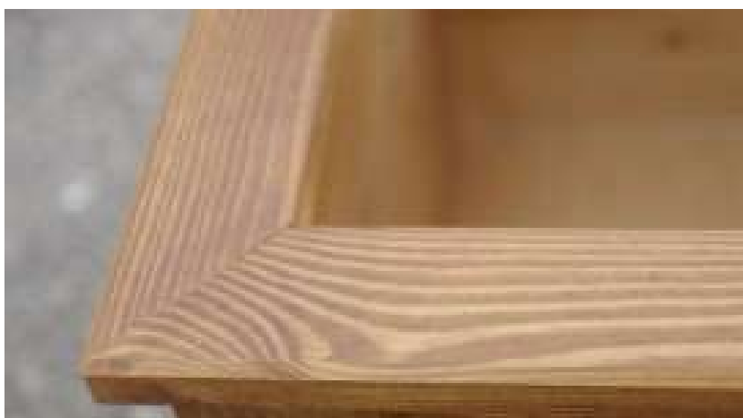
Ryc. 4 Sposób łączenia desek tworzących obramowanie podkładu.
